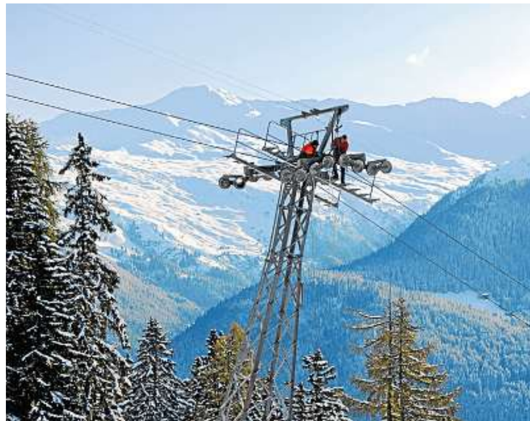
Letzte Vorbereitungsarbeiten am Sessellift auf Schatzalp: Montage der Rollenbatterien.
